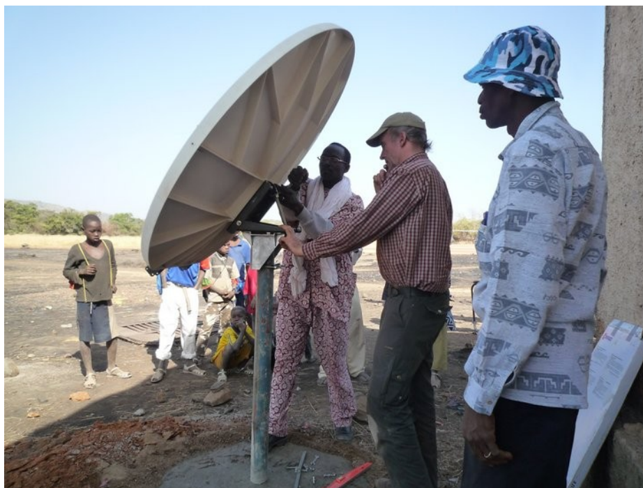
2011 : la première action : la mise en place d'une unité de communication, antenne satellitaire, accès téléphone et Internet pour désenclaver le village de Faléa
